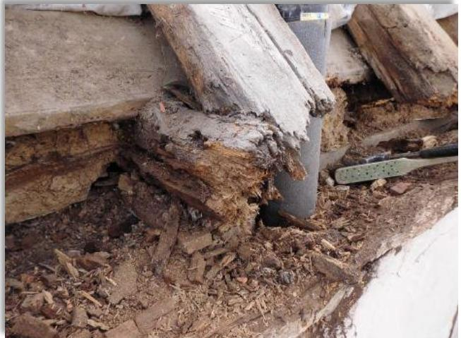
Das Wasser hat die daran angrenzenden Balken in Speicher und Dachkonstruktion teilweise verfaulen lassen. Ein Bild davon können Sie rechts oben sehen.
